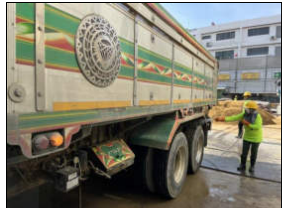
รูปที่ 2-9 กิจกรรมทำความสะอาดล้อรถบรรทุกก่อนออกนอกบริเวณโครงการ
