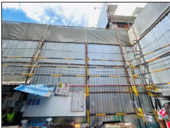
รูปที่ 2-2 รั้ว Metal Sheet
