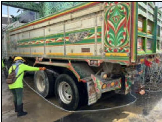
รูปที่ 2-9 กิจกรรมทำความสะอาดล้อรถบรรทุกก่อนออกนอกบริเวณโครงการ
