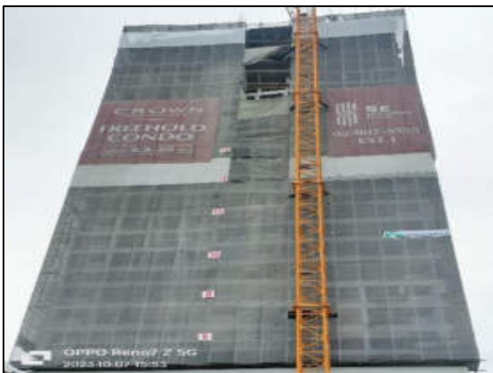
รูปที่ 2-45 Mesh Sheet
