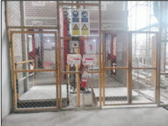
รูปที่ 2-5 ลิฟต์ขนย้ายเศษวัสดุก่อสร้าง
